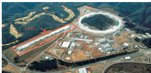
XFEL建屋の航空写真
