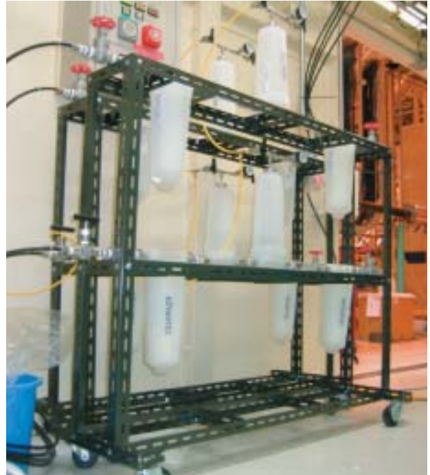
図4 分光器冷却水の脈動を抑えるためのフィルターおよびダンパー。黒いシフレックスチューブは冷却水用。黄色いシフレックスチューブはダンパー加圧用の圧縮空気用。
