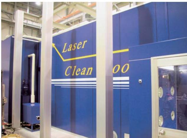
写真4 RF電子銃光源用レーザの長期安定化のための恒温恒湿クリーンルーム
