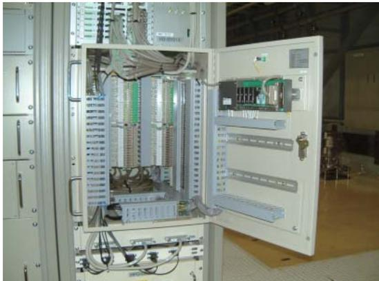
図2 線型加速器機器制御用コネクタボックス
