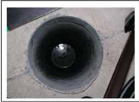
図2 亀裂部を含んでボーリングした。
