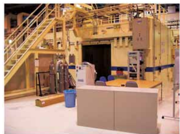
(d) 完成したピンポイント構造計測専用ハッチ
