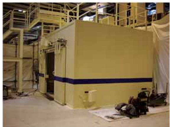
(b) ハッチ建設風景2 (2/28)
