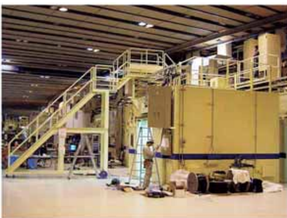
(c) ハッチ建設風景3 (3/9)
