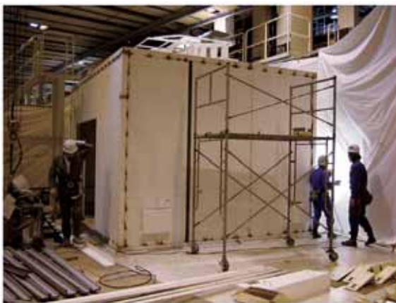
(a) ハッチ建設風景1 (2/22)
