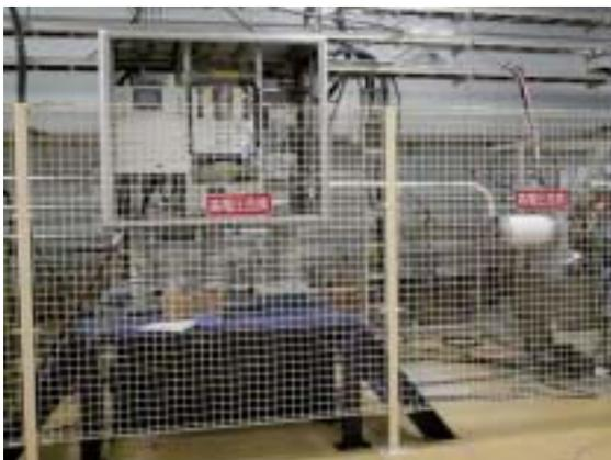
図2 加速管室に設置されたパルストランスタンク
