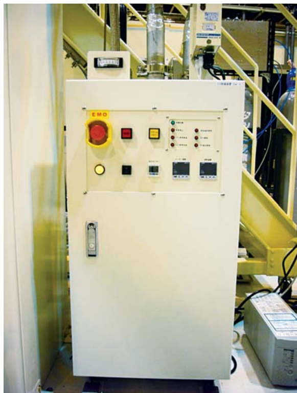
図2 CO除害装置
