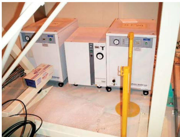
図3 ヘリウムコンプレッサ。三台並ぶ中央が新たに設置したもの。
