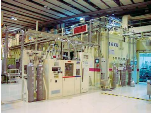
図9 サンビームに設置したその場計測用ガス設備
