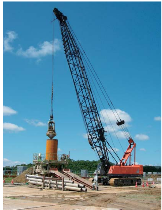
図12 加速器棟 杭工事
