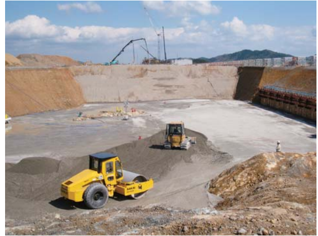
図15 光源棟 砕石置換工事
