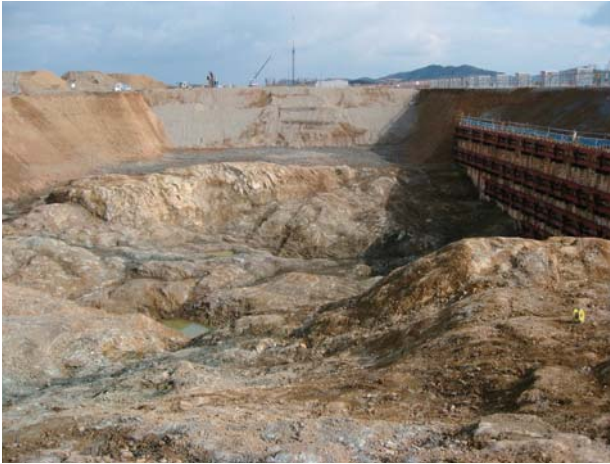
図14 光源棟 掘削工事
