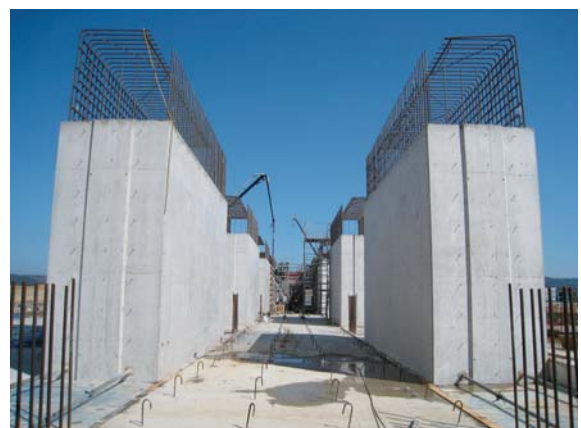
図13 加速器棟 加速器トンネル躯体工事
