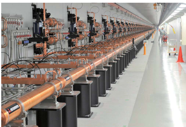
図4 Cバンド加速管128本、Sバンド8本の設置が完了
