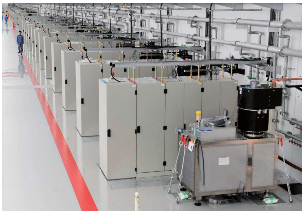
図5 モジュレータ電源、クライストロン、制御ラックの設置が完了
