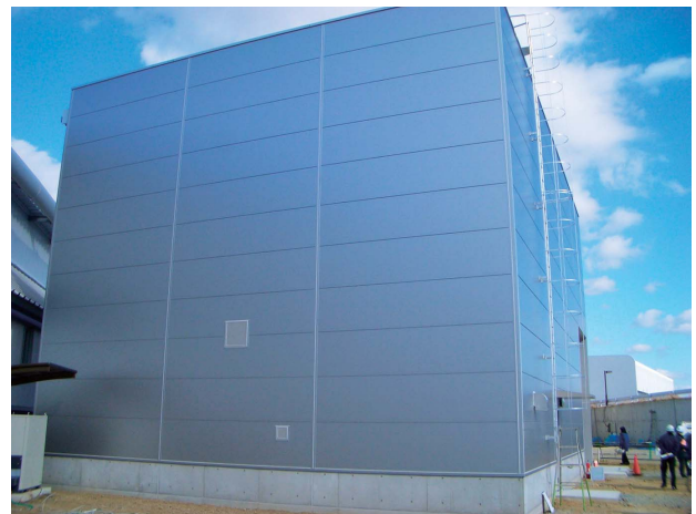
図1 理研・仁科加速器研究センターの協力により建設されたLEPS2実験棟
