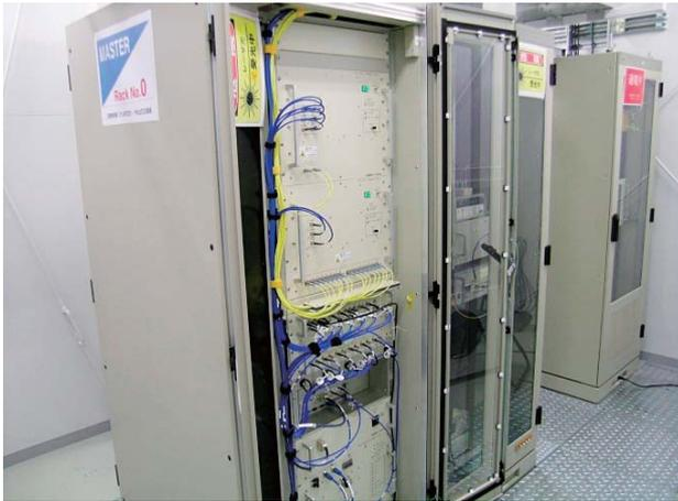
図7 マスターオシレータ室に設置された光タイミング・高周波分配システム
