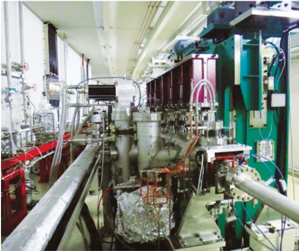
図4 蓄積リング34セルに設置されたクライオアンジュレータ実証機
