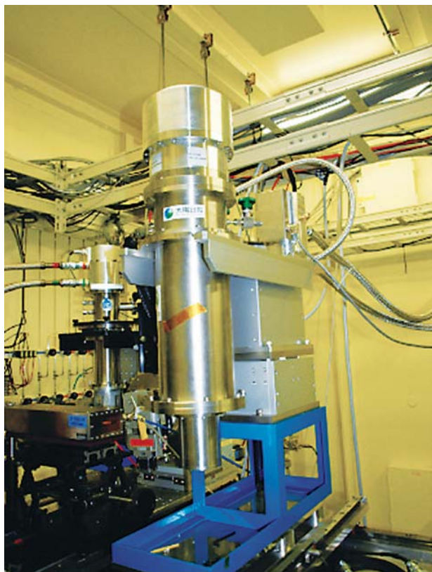
図1 実験定盤に設置された新規4 K冷凍機
