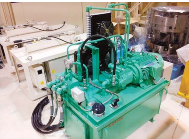
図1 SPEED-Mk.II用に設置された短周期変形装置
