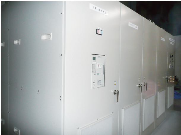
図2 BNLから移設した大型ソレノイド電磁石用に新規導入した、最大出力電流4800 Aの直流安定化電源。
