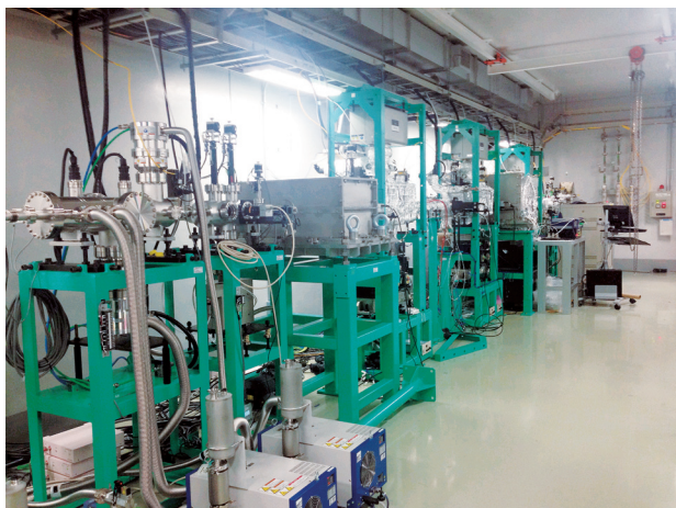
図4 光学ハッチ内に設置されたBL2のビームラインコンポーネント
