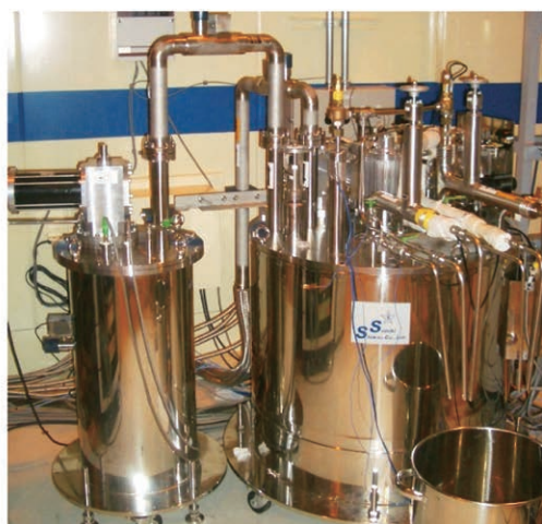
(a) 更新前(2+1冷凍機構成)
