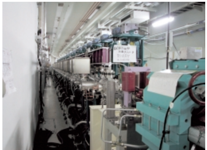
27m長真空封止アンジュレータ（外周側）。
