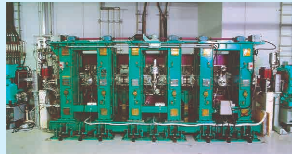
蓄積リング内に設置されたアンジュレータ
