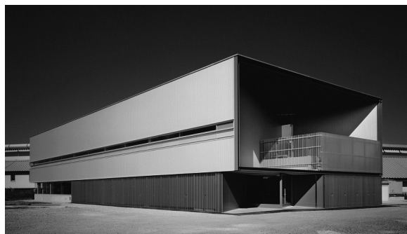
図5 豊田ビームライン実験棟の竣工写真
